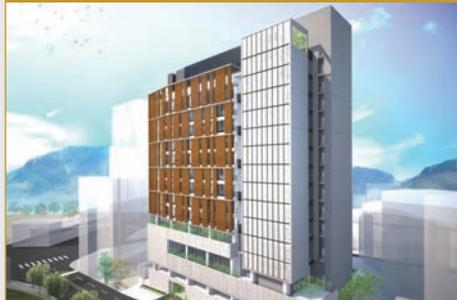
此為位於臺北市北投區的飯店工程，採 RC 造，地下 3 層，地上 14 層，總樓地板面積為 19521.88。該建案於 109 年 11 月 16 日開工，並於 112 年 9 月 4 日順利完工。建築設計以穩重純淨的淺色為基調，搭配棕色格柵，考量日照因素以提供舒適的視覺體驗。全程導入建築資訊模型系統 (BIM) 進行專案管理，提升施工效率與精準度。主要合作夥伴包括富邦人壽保險股份有限公司與大矩聯合建築師事務所。
